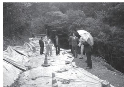
町道東細川1号線災害復旧現場
